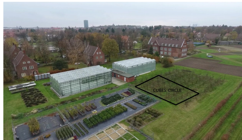
Zukünftiger Standort CUBES Circle
